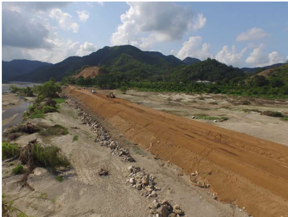
Construcción y reconstrucción de la infraestructura hidroagrícola
