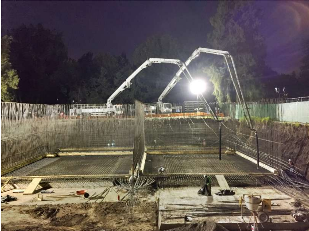
Construcción de la Planta de Tratamiento de Aguas Residuales en Chapultepec
